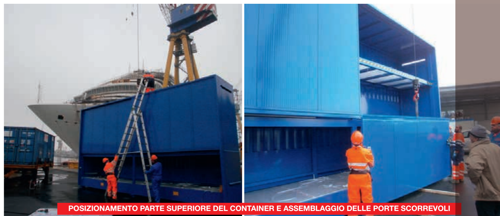
I CONTAINER A 3 PIANI SONO TRASPORTATI SU MEZZI ECCEZIONALI CADAUNO IN 2 PEZZI E ASSEMBLATI DA PERSONALE QUALIFICATO DIRETTAMENTE IN LOCO
