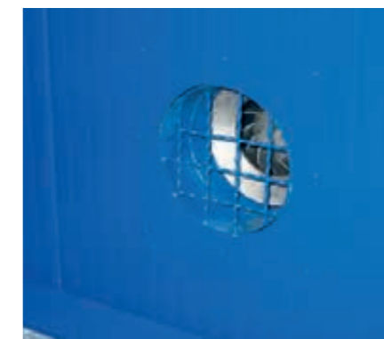
VISTA DEL PARTICOLARE ALL'INTERNO INSIDE VIEW OF THE DETAILS
