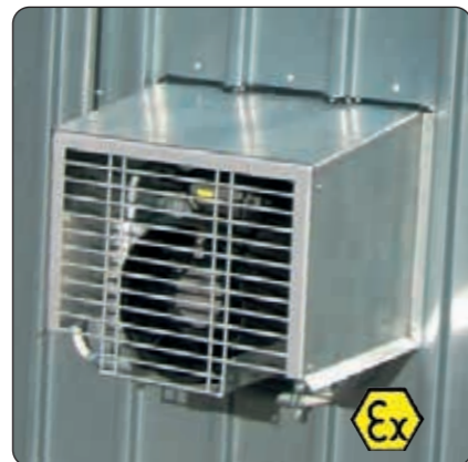
Ventilatore assiale certificato ATEX, capacità 10 ricambi / ora, completo di carenatura protettiva per impianto di ricambio aria forzato dell'ambiente di stoccaggio interno del container.
